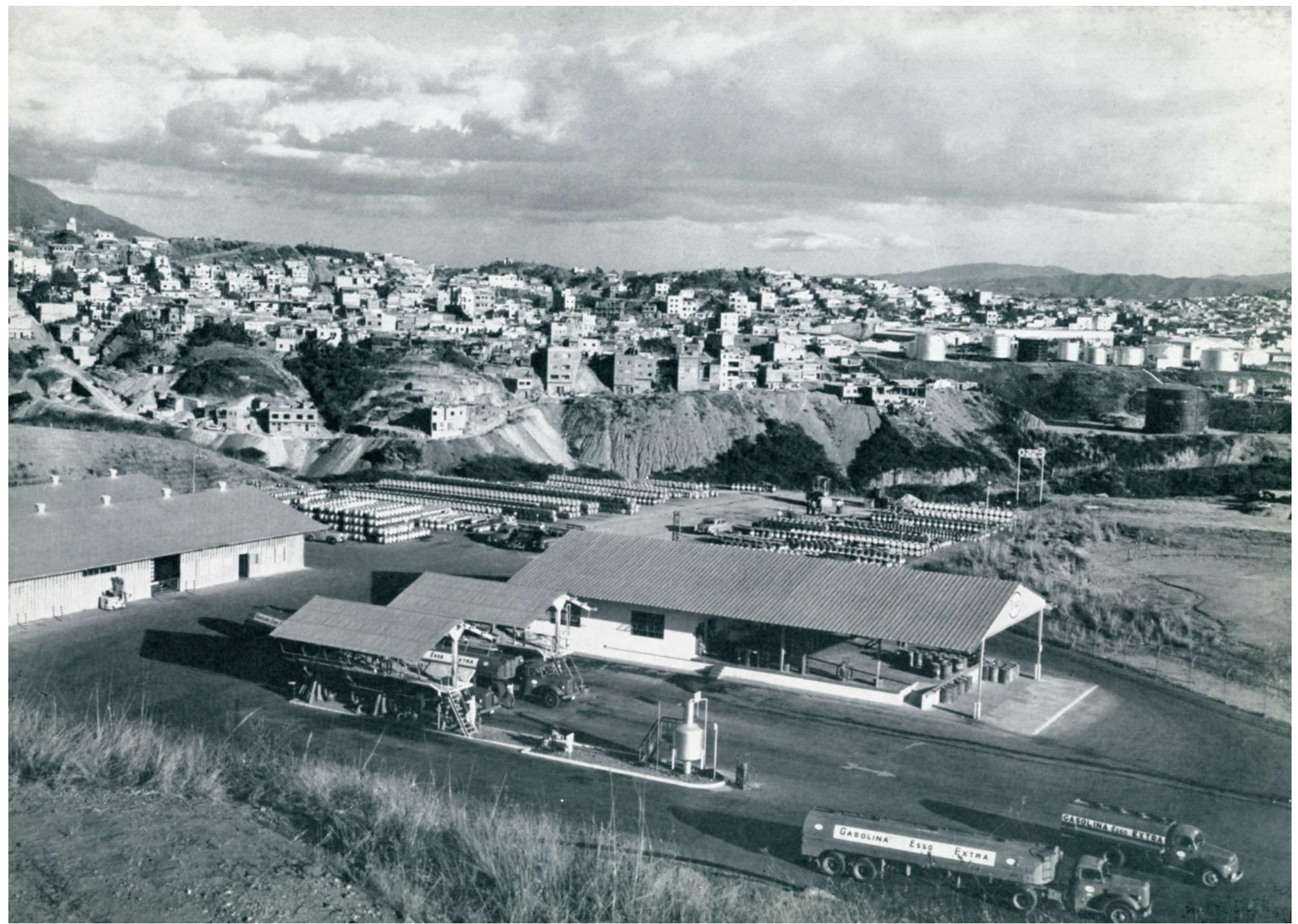
Una flota de camiones-tanques se encarga de distribuir la gasolina Esso Extra y corriente entre las estaciones de servicio. Los camiones-tanques corrientes tienen una capacidad de 6.000 litros; los de mayor tamaño, usados para surtir las bombas de fácil acceso, pueden transportar hasta 25.000 litros. Este servicio de camiones-tanques es uno de los últimos eslabones en el transporte de los derivados del petróleo.
